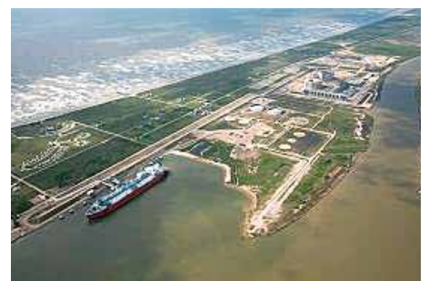
昨年7月に天然ガス液化加工能力を確保した米国フリーポートLNG基地。
