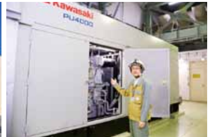
ガスタービン発電機：津波の影響を受けにくい海拔40mの高台に設置。送電線による外部電源や原子炉建屋内の非常用ディーゼル発電機が使えなかった場合に備えた電源
