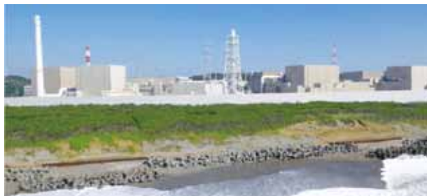
防波壁：海拔2.2m、総延長約1.6kmの壁で発電所敷地を取り囲み、両端部は海拔2.2～2.4mの改良盛土を設置。岩盤の中から立ち上げた鉄筋コンクリート造の地中壁基礎の上に、鋼と鉄骨・鉄筋コンクリートを組み合わせた構造のL型の壁部を結合するなど、地震や津波に対して粘り強い構造としている
