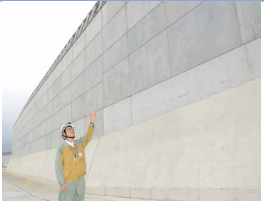
防波壁：海拔2.2m、総延長約1.6kmの壁で発電所敷地を取り囲み、両端部は海拔2.2～2.4mの改良盛土を設置。岩盤の中から立ち上げた鉄筋コンクリート造の地中壁基礎の上に、鋼と鉄骨・鉄筋コンクリートを組み合わせた構造のL型の壁部を結合するなど、地震や津波に対して粘り強い構造としている
