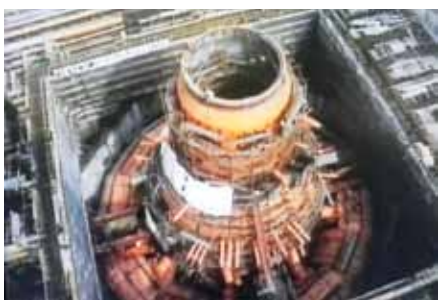
1号機原子炉格納容器据え付け(1972年)
