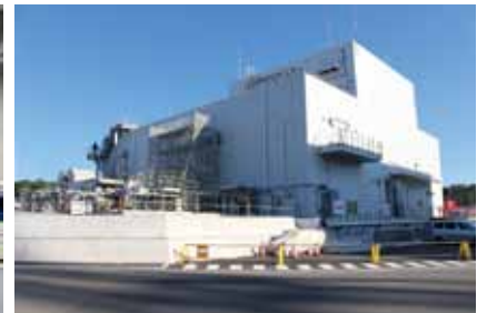
緊急時対策所：現在も新規制基準への適合性審査に係る一部の工事は継続しているが、建物本体は2017年3月に完成。建物は鉄筋コンクリート製で、壁や天井の厚さを最大2mまで厚くすることにより、緊急時対策所外の放射線に対する遮へい性を高めている
