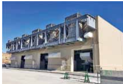
ガスタービン発電機：津波の影響を受けにくい海拔40mの高台に設置。送電線による外部電源や原子炉建屋内の非常用ディーゼル発電機が使えなかった場合に備えた電源
