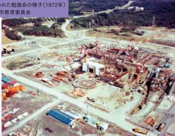
浜岡原子力発電所1号機建設の様子
