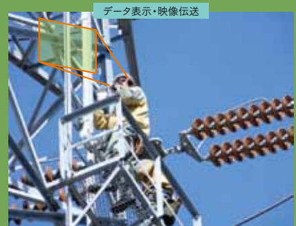
スマートグラスによる遠隔監視システム
