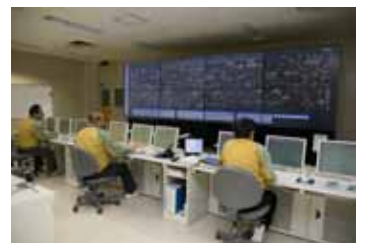
〔長野支店 長野給電制御所〕
