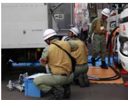
お客さま（模擬負荷）に電気を送るため、高圧発電機車を操作する。
