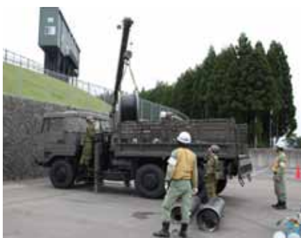
陸上自衛隊と協力して復旧資機材を運搬する。
