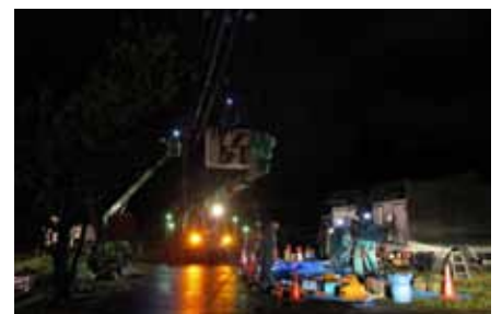
4月21日、22日には天候が悪化。大雨の中でも作業は続けられた。
