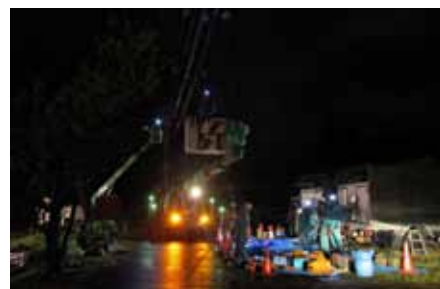
4月21日、22日には天候が悪化。大雨の中でも作業は続けられた。
