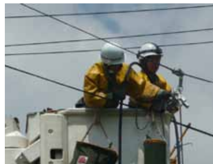
鉄塔が傾斜した停電エリアは復旧時間を要するため、高圧発電機車を配電線につなげて応急送電を実施。九州電力の指揮の下、他電力と協力し復旧に努めた。
