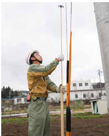
専用の計測棒で電柱、配電線の高さを測る。
