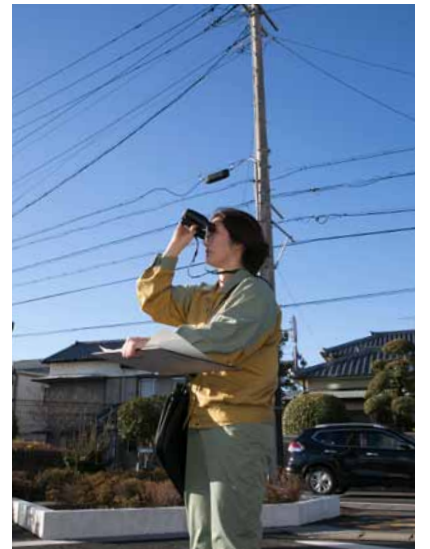
電柱に設置された変圧器などに異常がないかを確認。鳥の巣作りも要注意だ。
