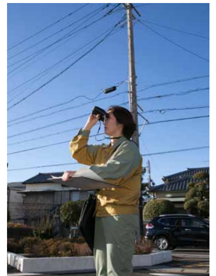
電柱に設置された変圧器などに異常がないかを確認。鳥の巣作りも要注意だ。
